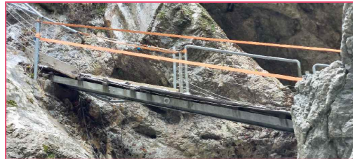
poškodovana jeklena rampa, kateri manjkajo ograjni elementi in jeklenica
